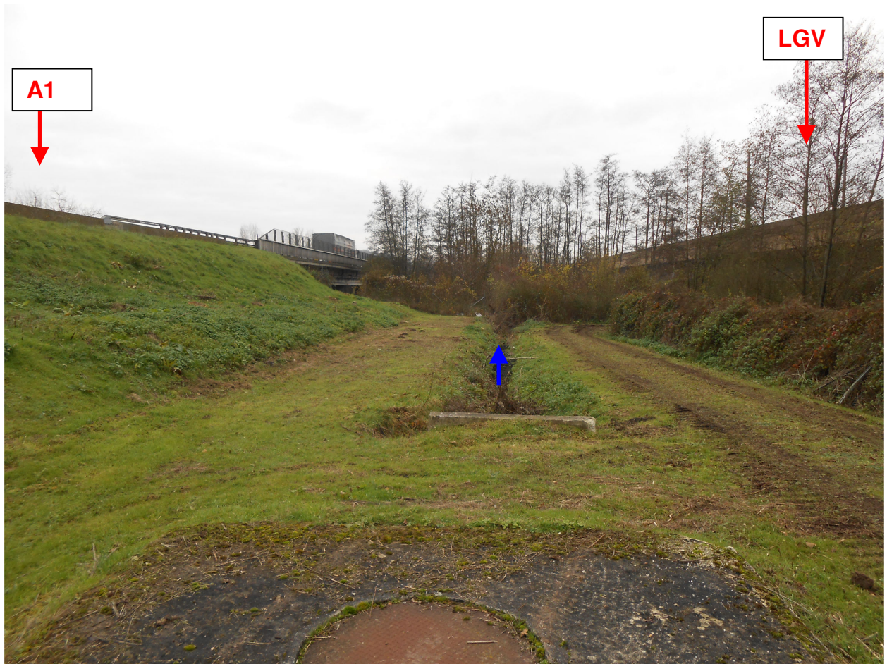
Photo n° N2 : fossé, exutoire des eaux pluviales vers la Somme
