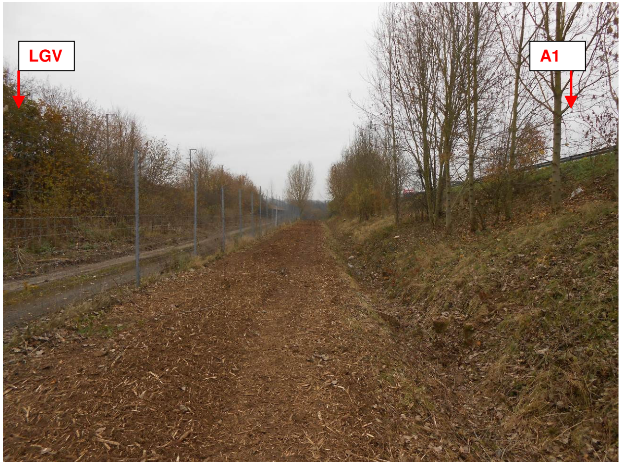
Photo n° S3 : vue du délaissé au Nord de la VC4 (PI 115 sous A1)
