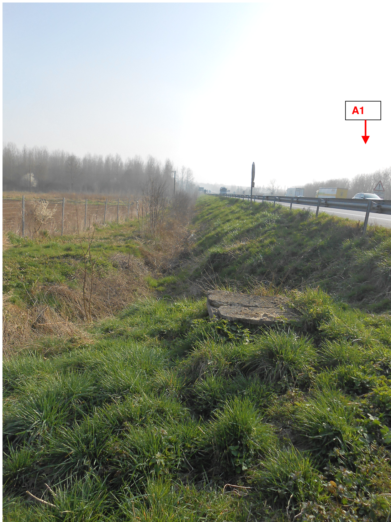
Photo n° N3 : vue de la zone de travaux au droit du délaissé entre la plateforme autoroutière et la clôture
