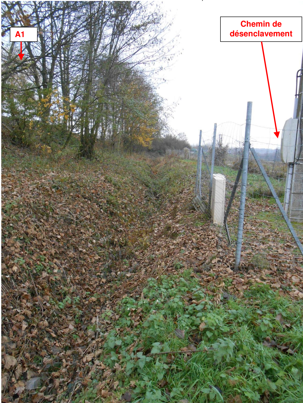
Photo n° S2 : Vue du délaissé entre le pied de remblai autoroutier et le chemin de désenclavement
