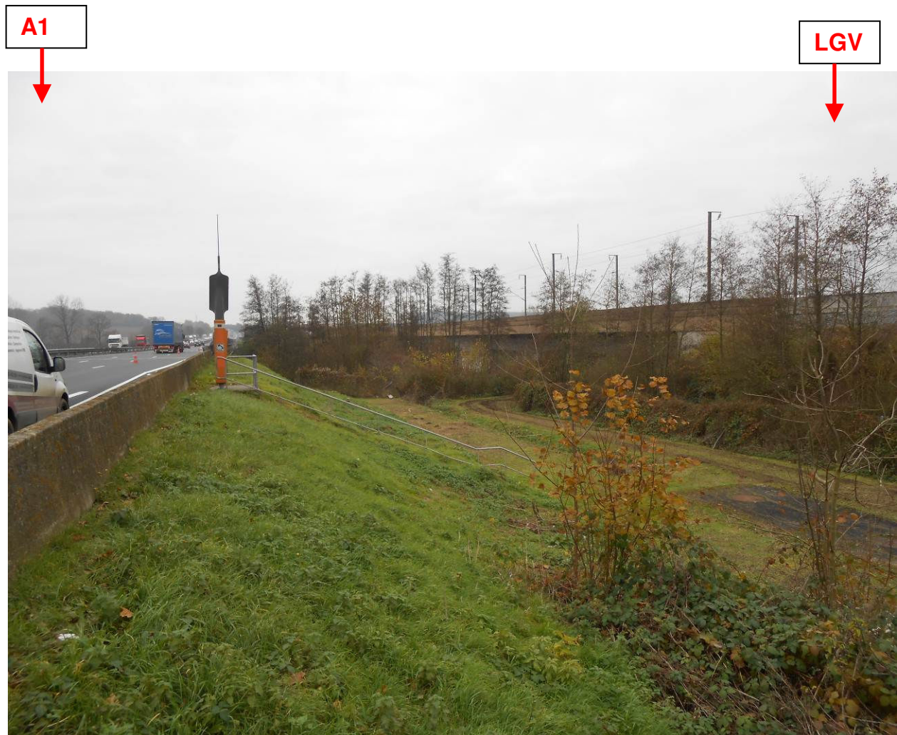
Photo n° N1 : vue générale du délaissé entre l'autoroute et la LGV vers la Somme
